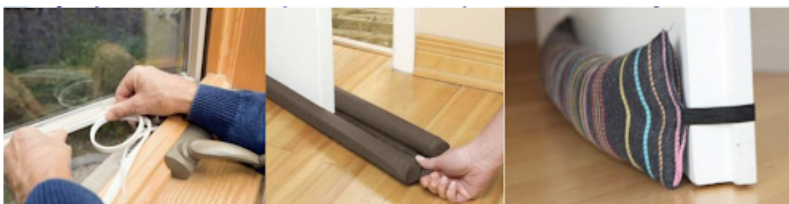
Figura 63. Estrategias de aislamiento térmico: burletes (Fundación Bariloche, 2021)
